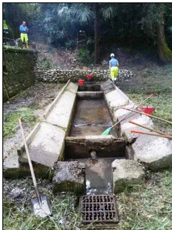
Il lavatoio dopo i lavori
