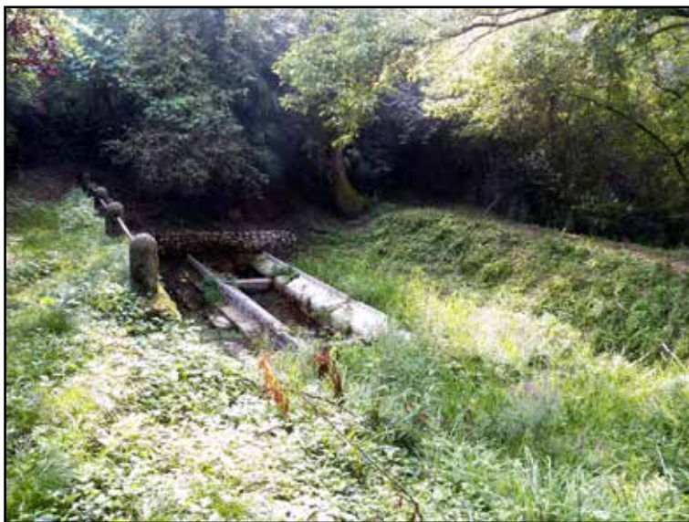
Il lavatoio prima dei lavori
